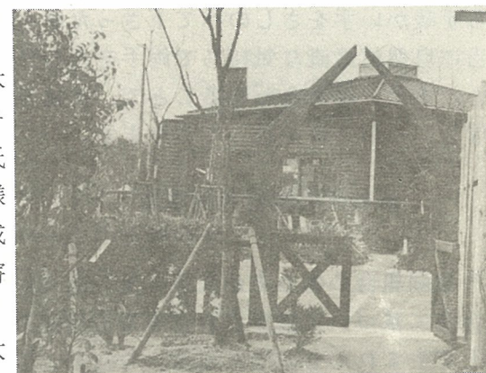
〈南側出入口アーチ〉
