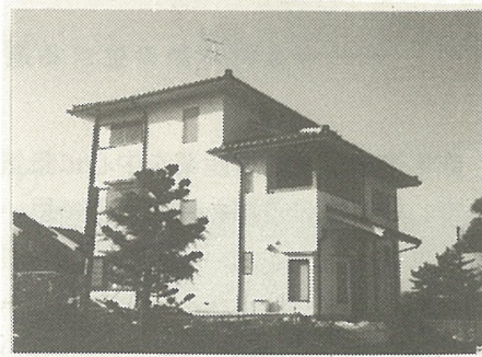
《完成なった木造3階建住宅》
