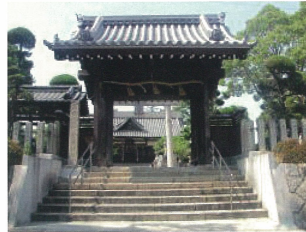
解体修理前の社殿と大門
