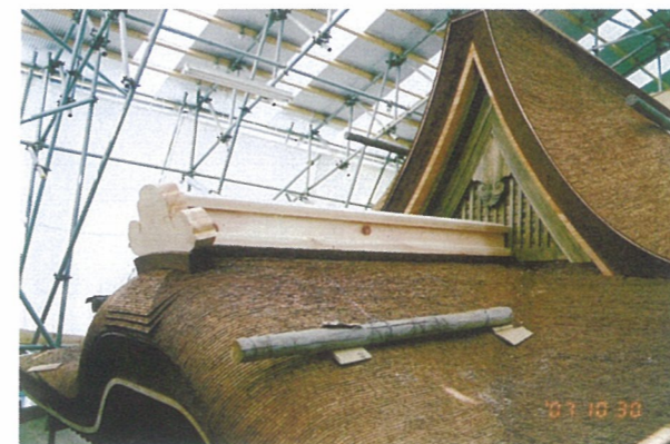
椽皮葺工事が完成したところ
