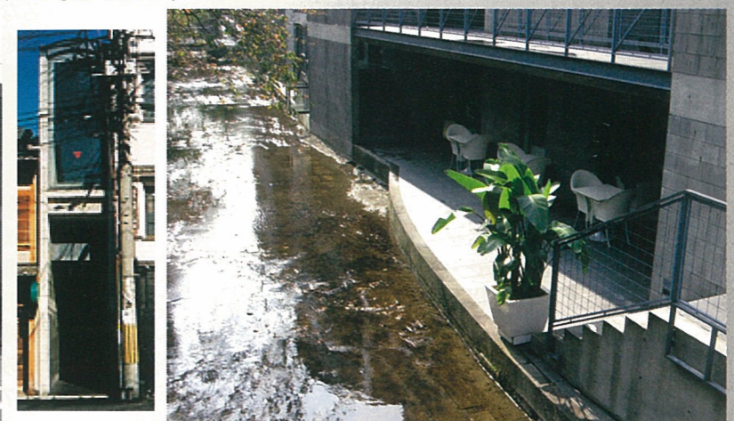
高瀬川の水と一体となっているテラス部分です。カフェテリアのオープンテラスとして使われていました。
