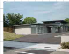
車両整備工場
