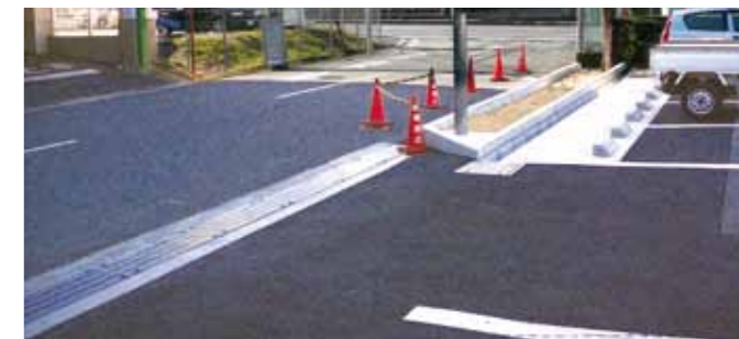
▲南側出入口の改修
