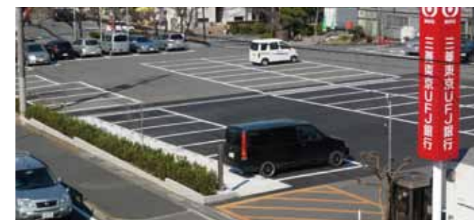
▲新設駐車場の整備
