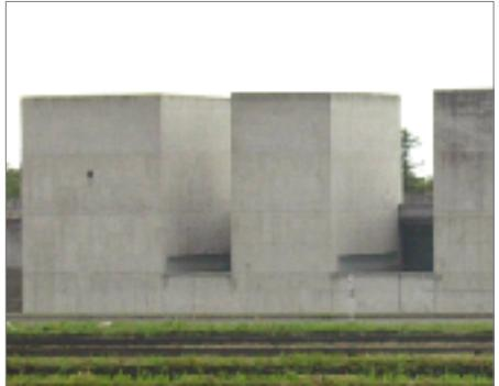
左端の建物に小さな(実は小さくない)穴が開いています。ここに直径600ミリの巨大レンズが設置されています。その建物の箱自体がカメラと同じ構造になっています。レンズをとおして内部の壁面に正面にある大山がくっきりと、写真と同じように上下左右さかさまに映し出されます。建物の内部は映像で植田正治氏や彼の作品の説明が紹介がされており、その後に、シャッターを切るようにレンズが開けられ、映像が壁面に浮かび上がるようになっています。
