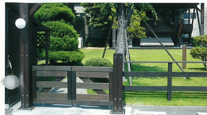
▲組合会館南西側の出入口門扉
